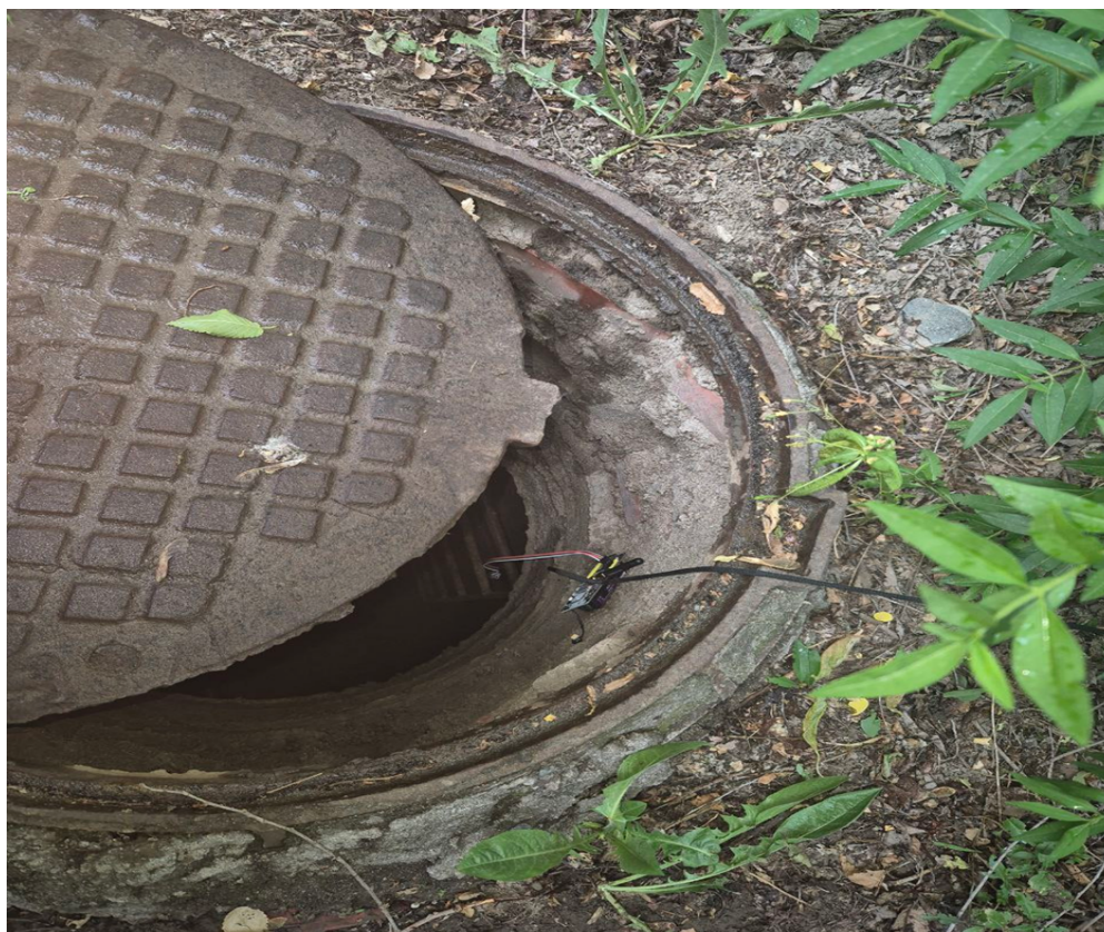
Рисунок 2.1 - Фото передающего устройства
